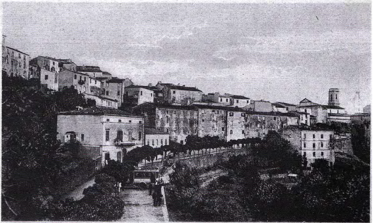
RIO ELBA - Viale Garibaldi
